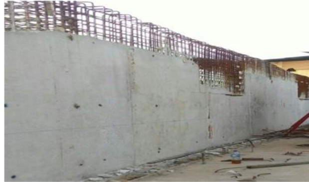
Gambar 2. Beton Hasil Pengecoran dengan Bekisting Panel Resin. (Sumber : Hasil Olahan, 2016)
