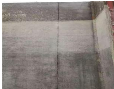
Gambar1. Beton Hasil Pengecoran dengan Bekisting Plat Baja.
